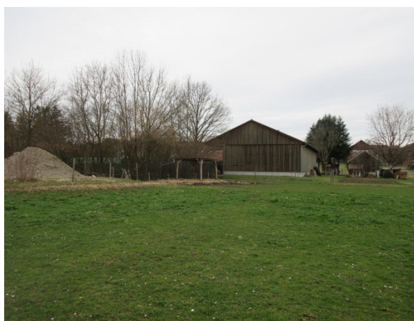
Foto 3: Blick nach Westen zum Gehölzbestand der Wertstoffsammelstelle und landw. Nebengebäude
