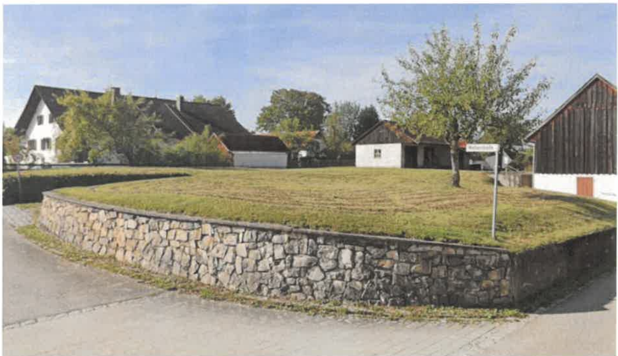
Abbildung 28: Geländeerhöhung und Natursteinmauer auf der Flurnummer 179, Blickrichtung von Osten nach Westen (GoogleStreetView, 2025)
