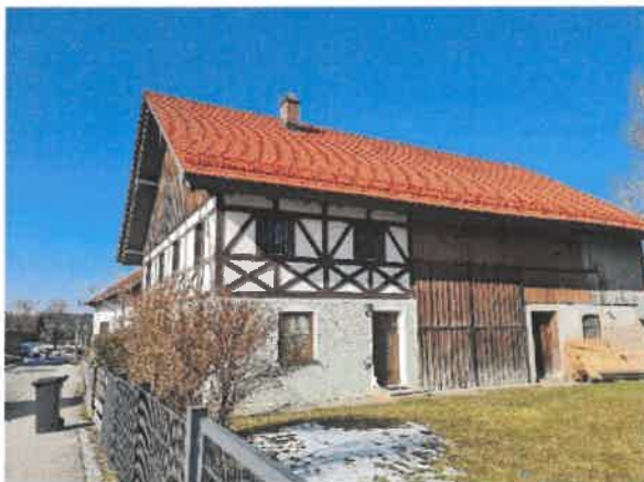
Abbildung 12: Hauptgebäude mit Wohntrakt zur Straße ausgerichtet (OPLA 2025)
