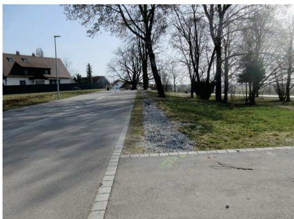
Foto 5: im Vordergrund der vorhandene Gasdrainagegraben zwischen Grünfläche und Baugebieten
